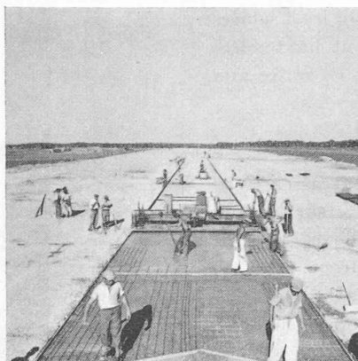
Fig. 9. — Le bétonnage de la dalle.
