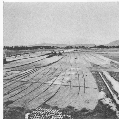
Fig. 12. — Vue générale du chantier.
