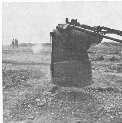
Fig. 10. — «Crapaud» pour pilonnage des remblais sous la piste. Le crapaud est en l'air, au sommet de sa course.
